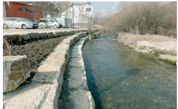
Neue terrassenähnliche Stufen zur Brenz
